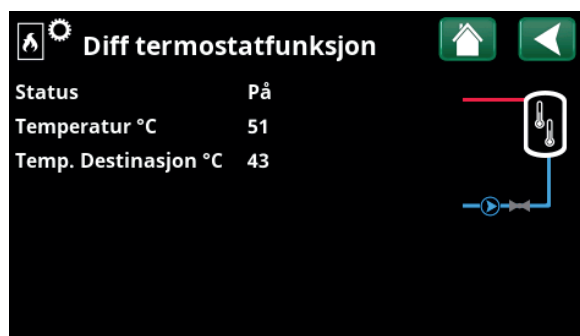
Meny «Driftsinfo/Diff termostatfunksjon».
