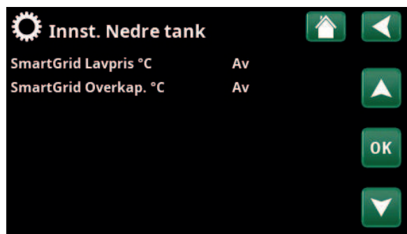
Meny «Avansert/Innstillinger/Nedre tank».
